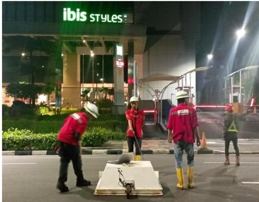
**Pemetaan utilitas bawah tanah** adalah survey yang menggunakan teknik geofisika untuk membuat representasi digital dari apa yang terkubur di bawah tanah. Survey ini menyusun profil bawah permukaan yang sangat rinci menggunakan teknologi terkini, termasuk peralatan Ground Penetrating Radar (GPR), dan Electro-Magnetic Locators (EML).
